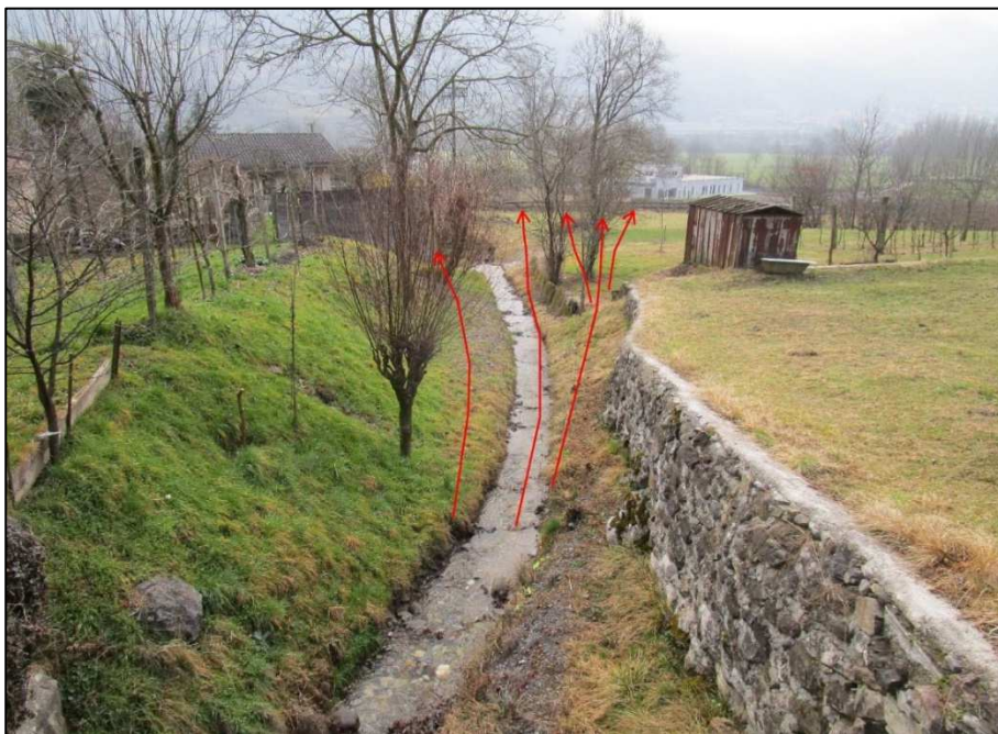
Fig. 58: Tratto d'alveo tra la sezione n. 8 e la sezione n. 6 con indicate le potenziali via d'uscita della colata detritica.
